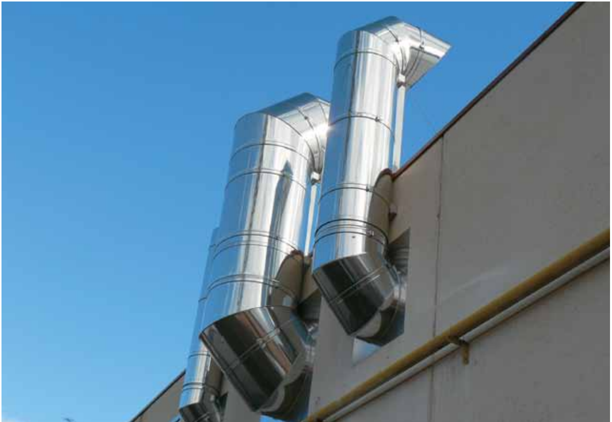
Instalación en conducto de acero inoxidable EI-30.
