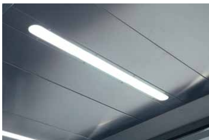
Las luminarias se integran en los techos filtrantes y campanas sin dejar rebordes difíciles de limpiar.
