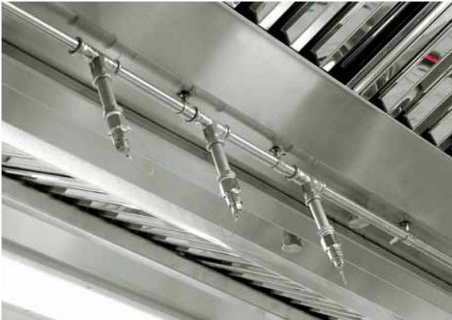
Boquillas y tuberías en acero inoxidable.
